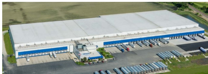
8. ábra: Hanson Logistics konszolidációs központ, Chicago (Hanson Logistics, 2017)
