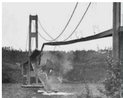
10. ábra: A Tacoma-híd katasztrófája
