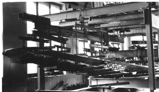
3. ábra: A hőskor: magyar fejlesztésű teljesen fémépítésű repülőgépszárny terhelésvizsgálata
