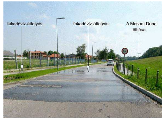
4.8. Fakadóvíz-átfolyás a mélyre épített úton
