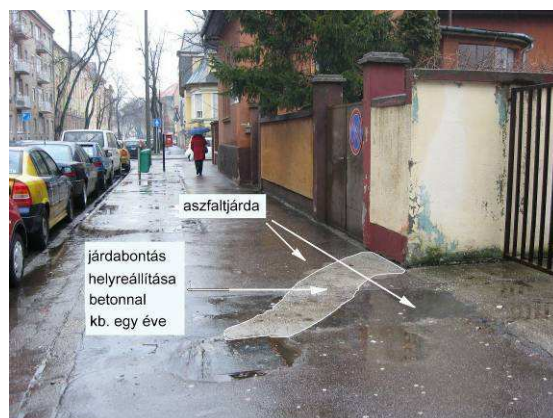
8.2. A betonos helyreállítás is maradandó
