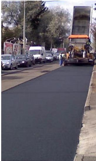
2. ábra Veszprémi útfelújítás KSGB alkalmazásával 2007 őszén
