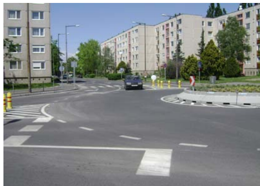
8. fénykép: A teljesen kiépített és használatba vett csomópont képe
