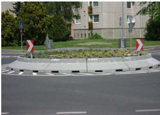
5. fénykép: Az előregyártott vasbeton elemekből kialakított középsziget növényzettel beültetve
