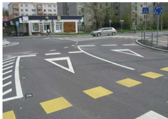
4. fénykép: Az egyenes-balos és a jobbra kanyarodó forgalmi irány belépési pontjának részlete az egyirányú kerékpárút átvezetésével
