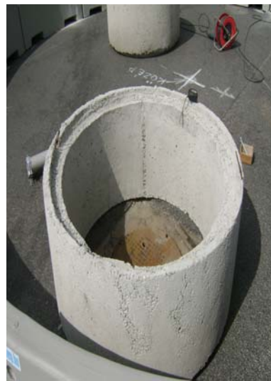
3. fénykép: Az előregyártott elemek által körbevett területen belüli csatorna akna megmagasítása kútgyűrűvel
