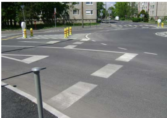
6. fénykép: A belépő irányok eltolt kialakítása növeli a kapacitást
